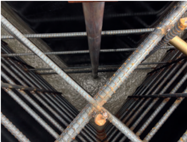
Abb. 3 und Abb. 4 zeigen den Betonierprozess. Auch wenn der SVB an einer einzigen Stelle, ohne den Trichter zu bewegen, eingebracht wird, verteilt er sich gleichmäßig. Dies ist bei der Verwendung von herkömmlichem Beton nicht der Fall.
