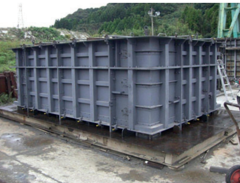
Abb. 1 und Abb. 2 zeigen die Schalung für die Herstellung des Rahmenquerschnitts mit einem Betongewicht von 12,3 t.
